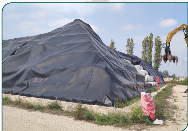
Fig. 3 • Copertura con teli in HDPE delle ecoballe
