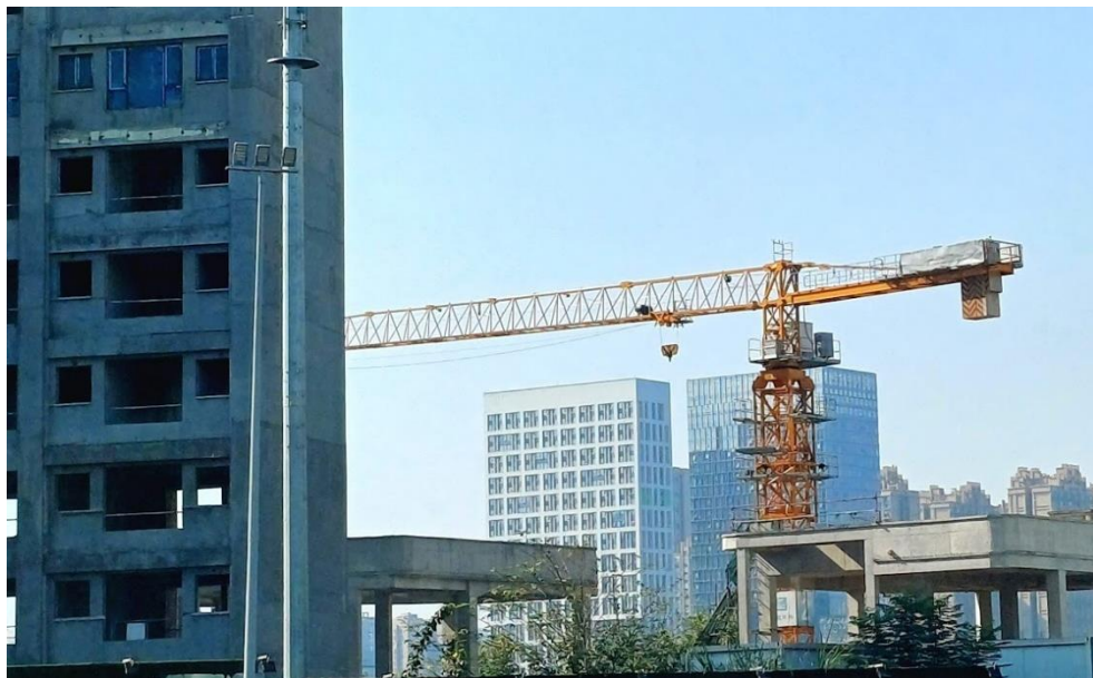
Figura 1. Edifici in costruzione
