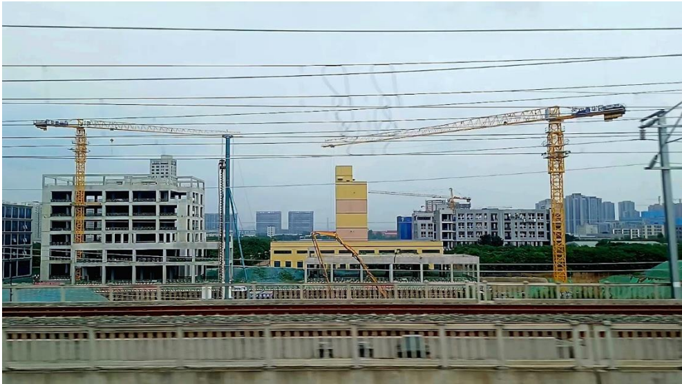
Figura 62. Edifici in costruzione
