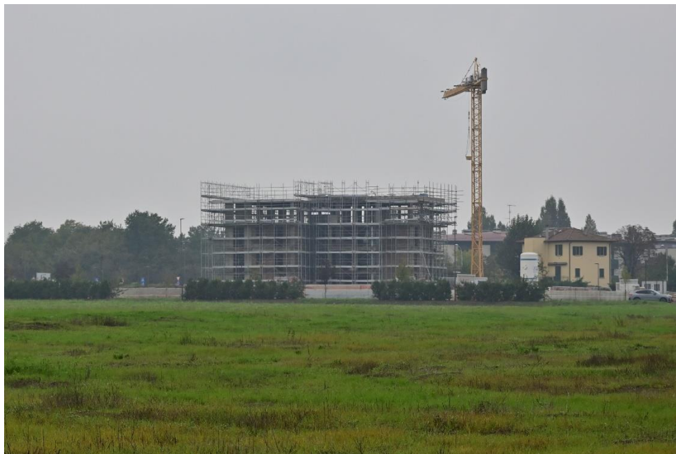
Figura 67. Nuova costruzione nel comune di Ozzano dell'Emilia, in provincia di Bologna, 28 ottobre 2024. Foto di Gianni Innocenti per il concorso fotografico “uno scatto per raccontare il cambiamento”
